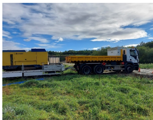
Poids-lourd avec compresseur en place pour foration Pz2
