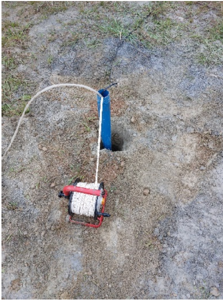
Pompage de nettoyage / développement en phase de cimentation
