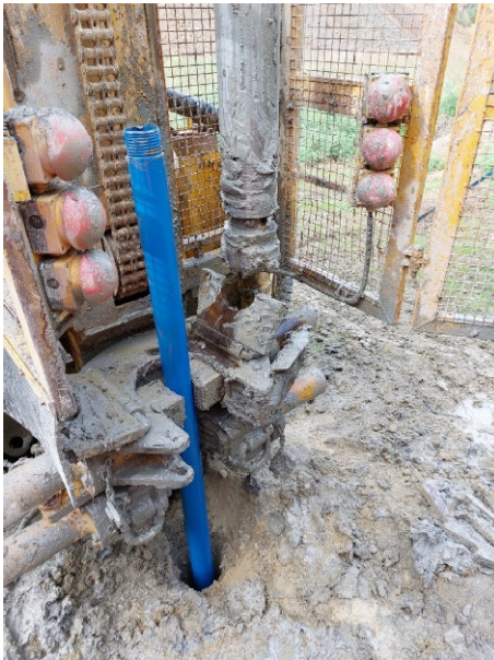
Mise en place tubage PVC
